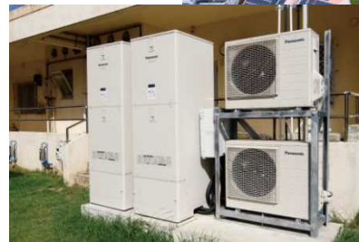
市営住宅に設置されたネットワーク型エコキュートが、需給調整と温水提供を兼ねる
