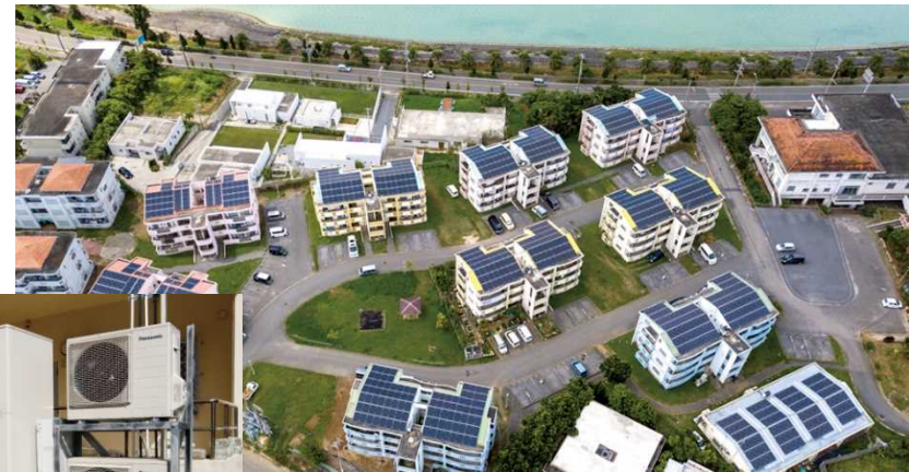
市営住宅に設置されたネットワーク型エコキュートが、需給調整と温水提供を兼ねる
